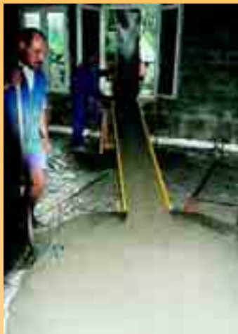
Szybsze układanie betonu i łatwiejsze wykończenie powierzchni przy zmniejszonych nakładach robocizny i pracy sprzętu.
