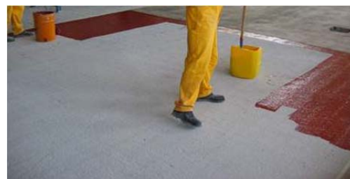
Gruntowanie materiałem Sikafloor®-155 WN
