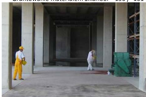
Gruntowanie materiałem Sikafloor®-156 / -161
