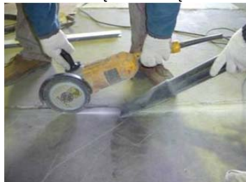
Bruzdownica z pojedynczą tarczą (nie daje tak dobrych rezultatów)
