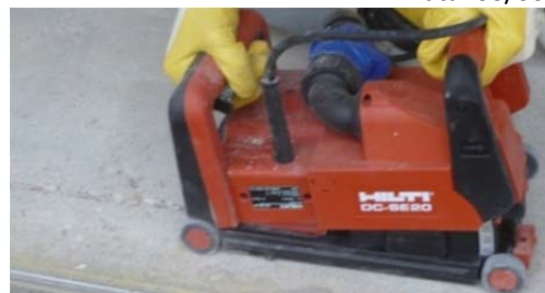
Bruzdownica z podwójną tarczą
