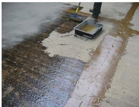
Gruntowanie materiałem Sikafloor®-156 / -161
