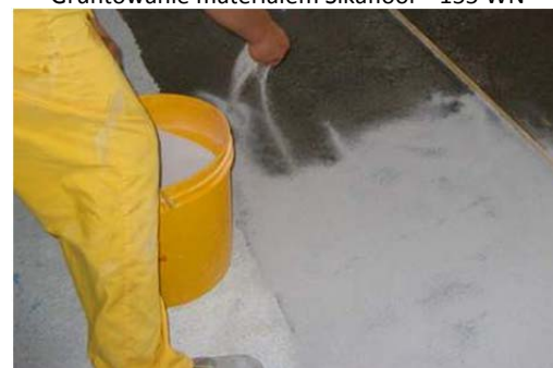
Gruntowanie materiałem Sikafloor®-155 WN
