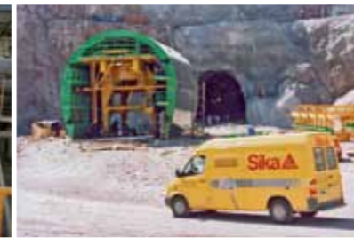
Dostawa na budowę
