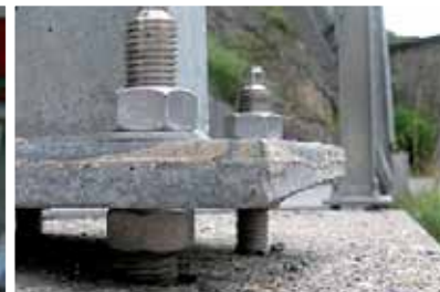
Kotwienie: wkładanie gwintowanych śrub i prętów zbrojeniowych
