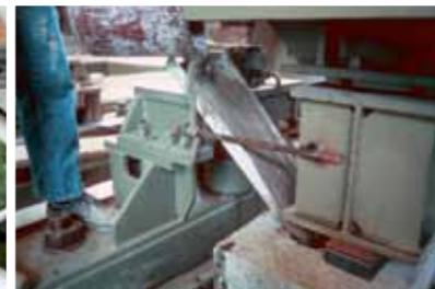
Podlewka pod podstawę maszyny
