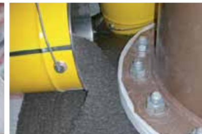
Podlewka z zaprawy epoksydowej
