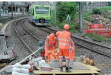
Podlewka płyty stalowej
