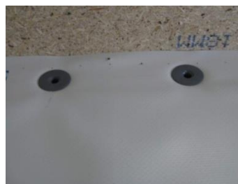
Mocowanie mechaniczne za pomocą podkładek
