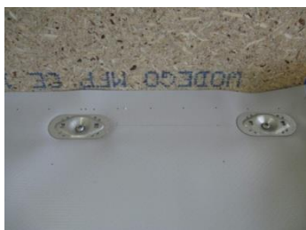
Mocowanie mechaniczne za pomocą metalowych dysków
