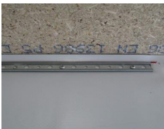
Mocowanie mechaniczne za pomocą profili Sarnabar®
