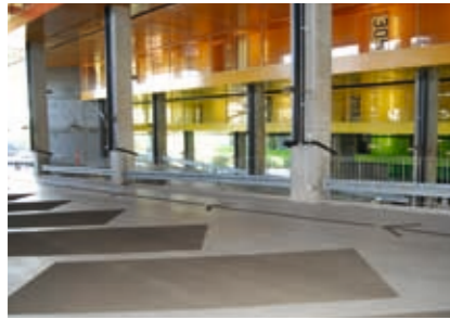
Posadzki i powłoki ochronne Strona 8
