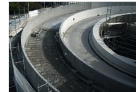
Konserwacja i naprawa betonu Strona 24
