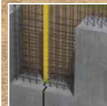
Szczeliny przylegające przy ścianie szczelinowej
