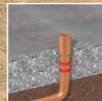
Uszczelnianie przejść przez konstrukcję
