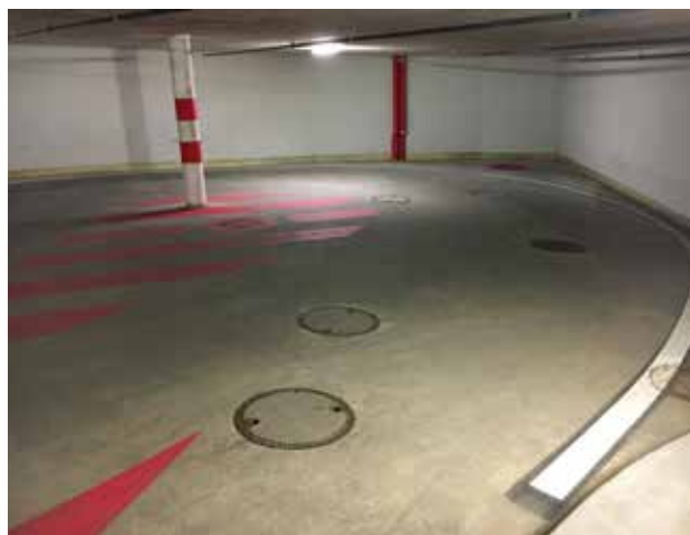
Parking Villar sur Ollon, wykończenie przez zacieranie - szcztokowanie.
