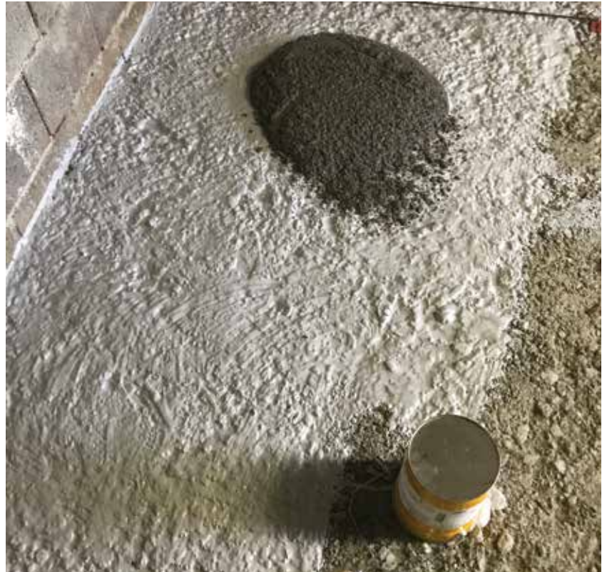
Wytrzymałość połączenia nigdy nie będzie wyższa niż wytrzymałość na rozciąganie podłoża.
