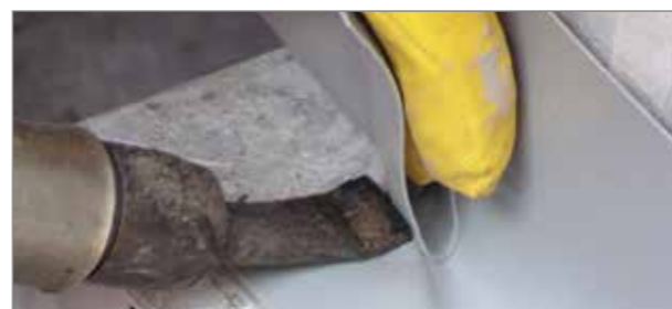
■ 4. Połączenie taśm za pomocą zgrzewania
