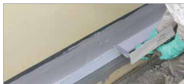
■ 5. Naniesienie górnej warstwy kleju na ułożoną taśmę uszczelniającą
