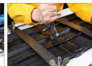
Zakładanie pasów kryjących, dociskanie obydwu pasów kryjących
