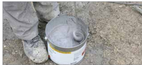
■ 1. Mieszanie kleju Tricoflex® FU 60
