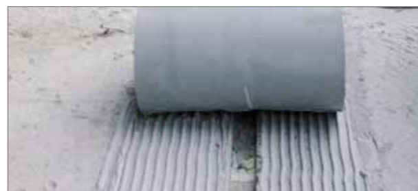
■ 3. Ułożenie taśmy uszczelniającej
