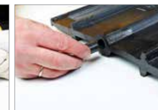
Korkowanie otworu centralnego przy pomocy zatyczki z pianki i wsunięcie zatyczki z surowego kauczuku
