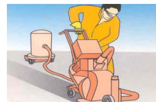
Przygotowanie podłoża: np. metodą strumieniowo-ścierną. Wyposażenie np. Blastrac.
