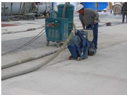
Obróbka strumieniowo-ścierna
