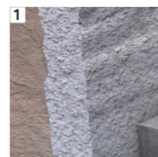
1 Beton natryskowy (warstwa zewnętrzna)
