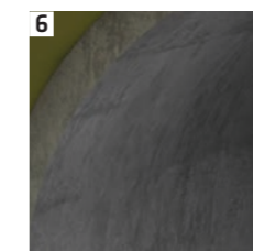
6 Konstrukcja żelbetowa tunelu (obudowa właściwa)
