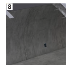
8 Wewnętrzna warstwa betonu
