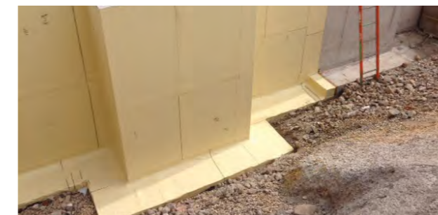
Otwarty wykop z wystającą płytą (odsadzką) – w tym przypadku cała konstrukcja może być w prosty sposób uszczelniona za pomocą SikaProof® P.
