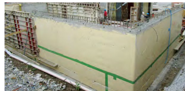
Otwarty wykop z SikaProof® A, po usunięciu deskowania otwory na kotwy/ściągę muszą być uszczelnione.
