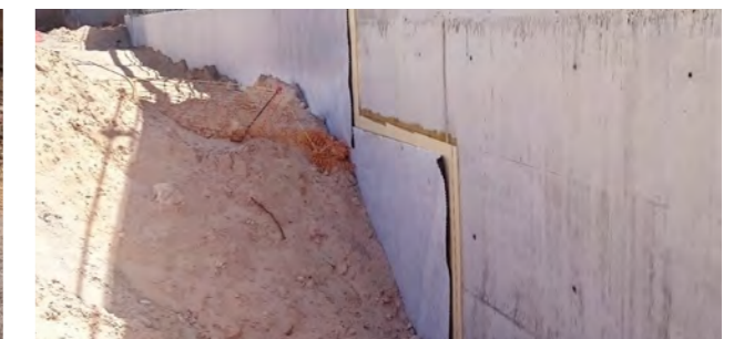
W otwartych wykopach bardzo istotna jest ochrona membrany SikaProof®, szczególnie podczas ich późniejszego zasypywania.
