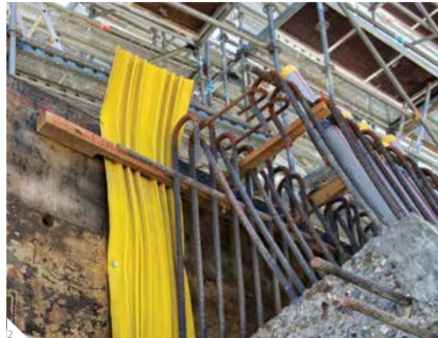
2 Technologia „białej wanny” Sika White Box / Beton wodoszczelny Sika® Watertight Concrete
