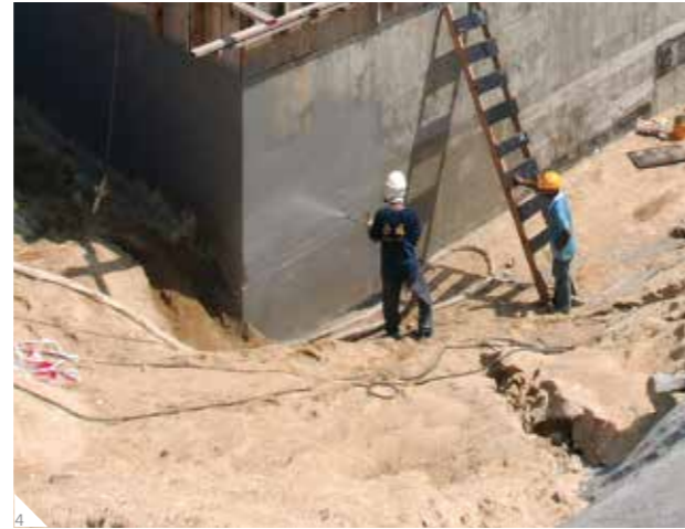
4 Powłoki wykonywane z płynnych systemów żywic reaktywnych (PUR/PUA)
