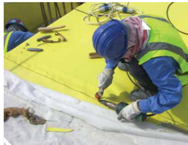
6 System izolacji z membran z podziałem na wodoszczelne sekcje
