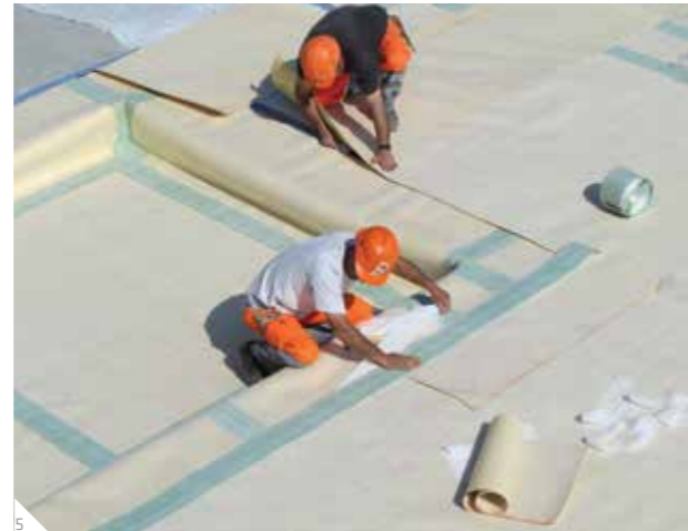
5 Membrany przylegające do konstrukcji na całej powierzchni
