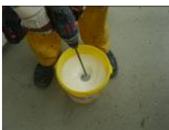
Mieszanie Sikafloor®-304 W
