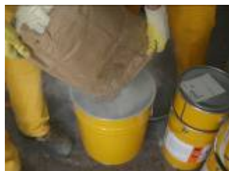
Mieszanie Sikafloor®-169 i Sikafloor®-DecoFiller
