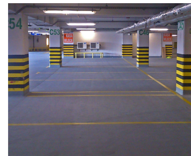
NATRYSK MEMBRANY HYDROIZOLACYJNEJ SIKALASTIC®-8800
