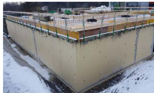
Otwarty wykop z SikaProof® A+, po usunięciu deskowania otwory na kotwy/ściągę muszą być uszczelnione.
