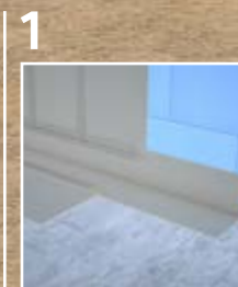
1 SikaProof® A+ membrana układana przed wykonaniem konstrukcji
