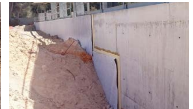
W otwartych wykopach bardzo istotna jest ochrona membrany SikaProof®, szczególnie podczas ich późniejszego zasypywania.
