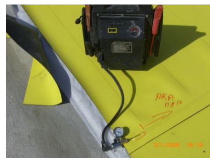
Badanie ciśnieniowe podwójnego zgrzewu z pompą elektryczną
