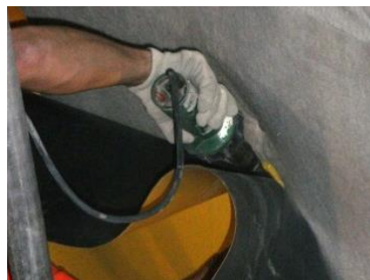
Zgrzewanie ręczne
