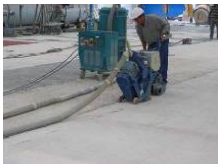
Śrutowanie z jednoczesnym odkurzaniem
