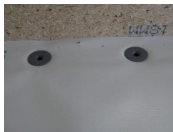
Mocowanie mechaniczne za pomocą podkładek
