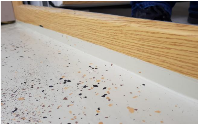
Doszczelnienie styku posadzka - okno balkonowe
