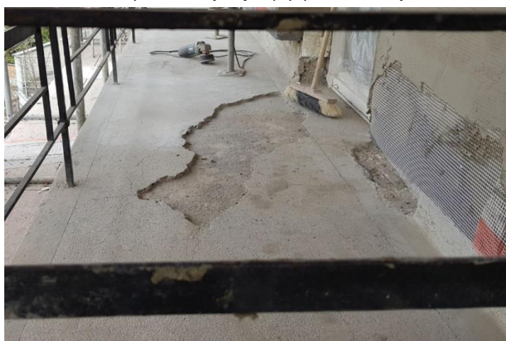
Ubytki podłoża
