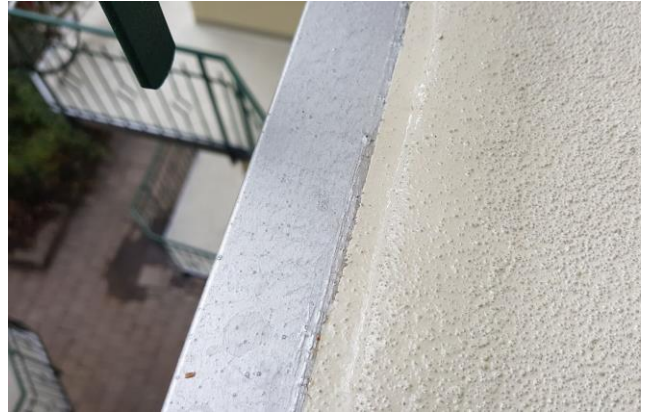
Doszczelnienie styku posadzka - obróbka blacharska
