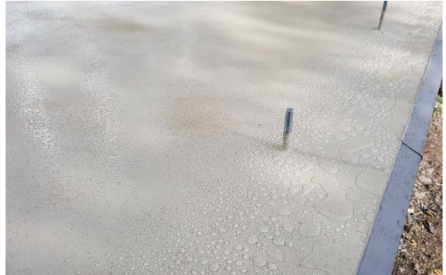
Doszczelnienie szpilek pod mocowanie balustrad
