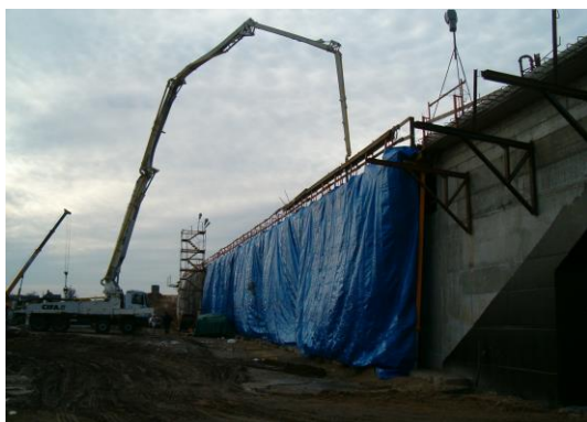
Fot. 14. Wiadukt w ul. Głogowskiej w Poznaniu. Realizacja obiektu odbywała się w okresie jesienno-zimowym co dodatkowo powodowało trudności z realizacją obiektu
