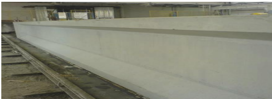
Fot. 13. Dźwigar mostowy wykonany w technologii SCC – rok 2010
