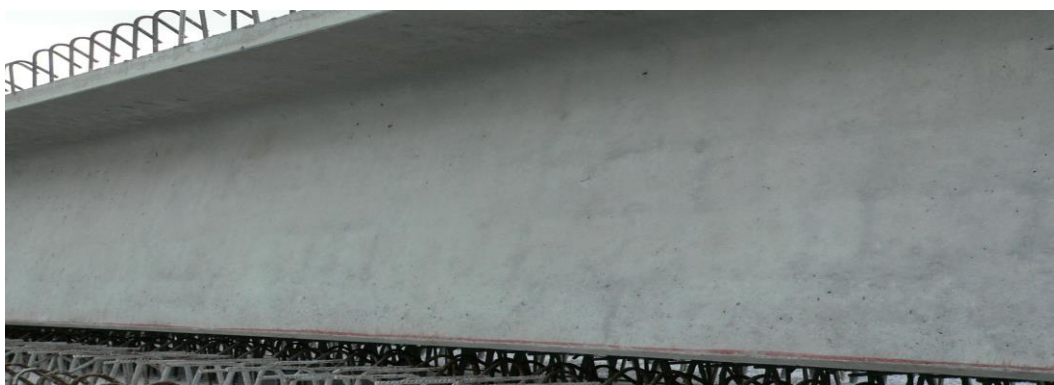
Fot. 9. Dźwigar mostowy – technologia SCC ( bez szpachli i malowania)
