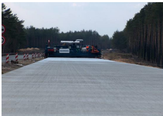
Fot. . Budowa drogi kołowania oraz gotowa płaszczyzna postoju samolotów na lotnisku w Krzesinach.
