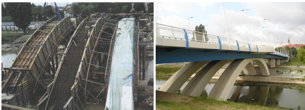
Fot 3. Budowa i wygląd końcowy, pierwszego w Polsce, wykonanego całkowicie w technologii betonu SCC, Mostu Zamkowego w Rzeszowie.
