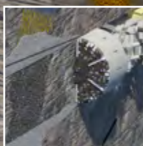
Iniekcje czoła przodka przed głowicą TBM
