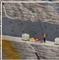
Zatrzymywanie napływu wody
