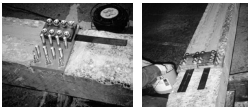
Rys. 4. a) Zakończenie sprężania pierwszej taśmy na belce, b) zakończenie sprężania drugiej taśmy
