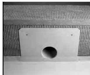
Umieść wpust ścienny we właściwym miejscu i przytwierdź go mechanicznie conajmniej 4 łącznikami. Istotne jest to, aby krawędź pozioma przelewu znajdowała się pod (wprowadzoną na płaszczyznę pionową) membraną. Oczyszć powierzchnię przed zgrzewaniem.
