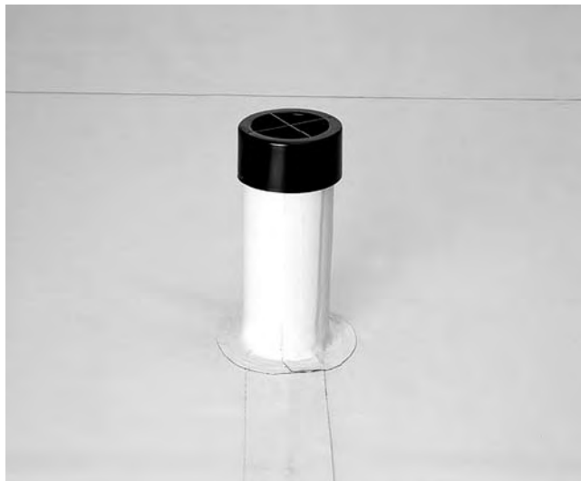
Widok na wykończoną obróbkę wywiewki dachowej.
