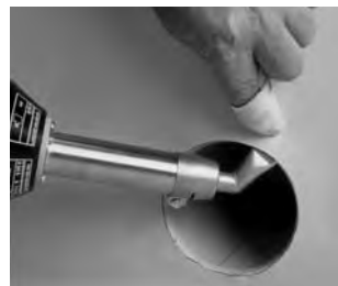
Wytnij fartuch z membrany niezbrojonej z otworem dostosowanym do średnicy wpustu ściennego i przygrzej go do płaszczyzny pionowej wpustu.
