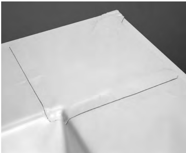
Widok na wykończony narożnik wewnętrzny ściany attyki.
