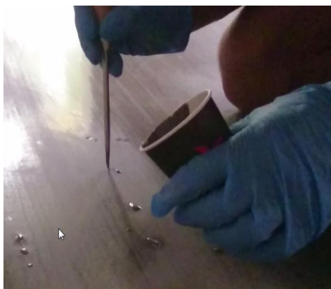
Fot. 10: Wypełnianie dziurek za pomocą szpikulca
