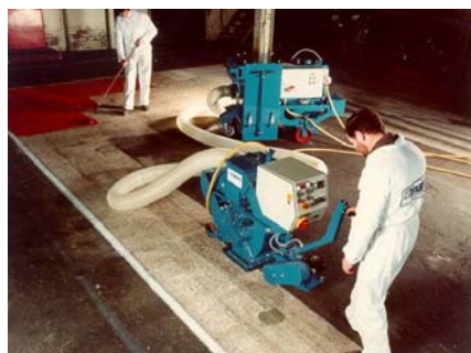
Obróbka strumieniowo-ścierna
