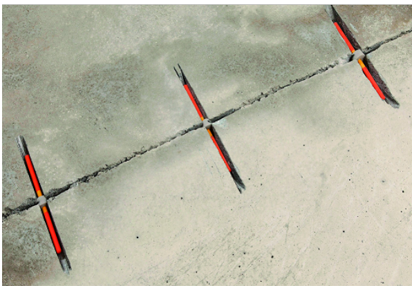
Rozmieszczenie klamer w naciętych bruzdach Iniekcja ciśnieniowa przez pakery iniekcyjne wiercone
