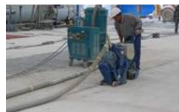
Przygotowanie podłoża: metoda strumieniowo-ścierna lub inna mechaniczna. Np. Blastrac.
