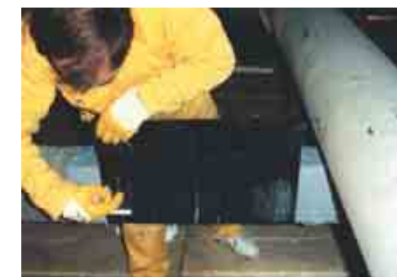
Wzmocnienie stref ścinanych matą kompozytową z włókien węglowych SikaWrap®
