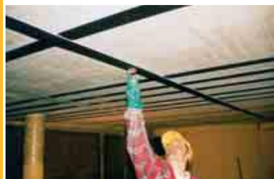
Wzmocnienie żelbetowej płyty stropowej taśmami węglowymi Sika® CarboDur®
