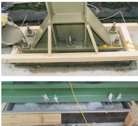
Rysunek 1. Po lewej: Przykładowe rozwiązanie dla zapewnienia odpowiedniej wysokości podawania zaprawy. Po prawej: rozwiązanie deskowania
