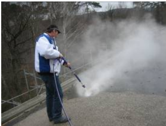
Oczyszczanie gorącą wodą pod ciśnieniem. Np. Falch lub Kärcher
