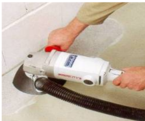
Bezpyłowe szlifowanie podłoża
