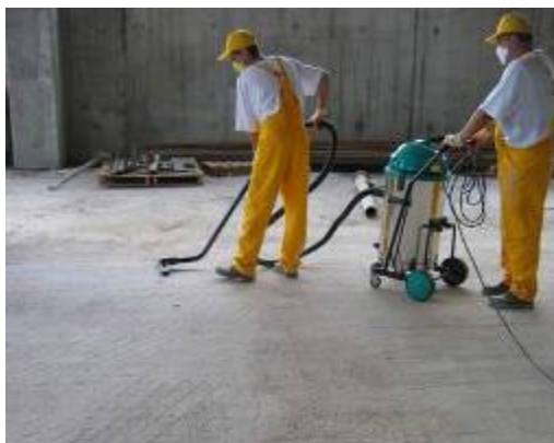
Odkurzanie podłoża po szlifowaniu
