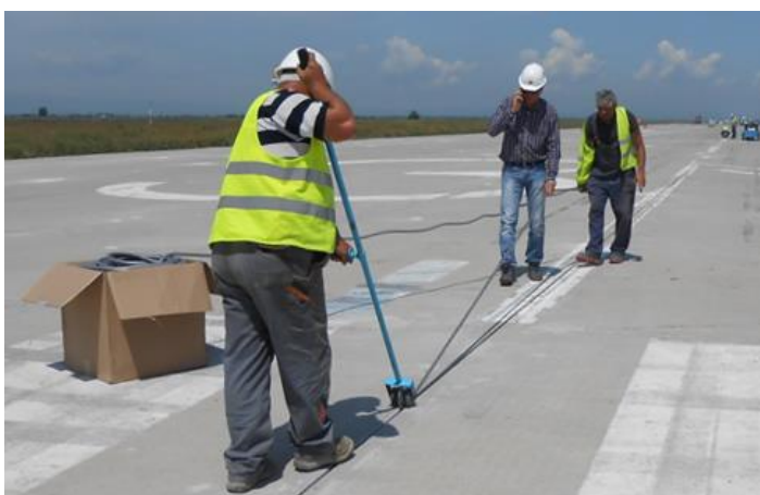
Zdjęcie 1: Układanie podparcia wypełnienia za pomocą narzędzi.
