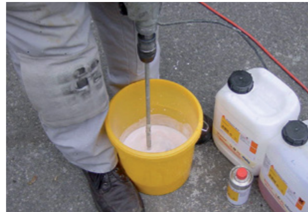
Mieszanie żywicy iniekcyjnej Sika na bazie akrylu
