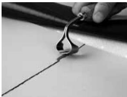
Fazowanie membrany w miejscu zgrzewania taśmy uszczelniającej
