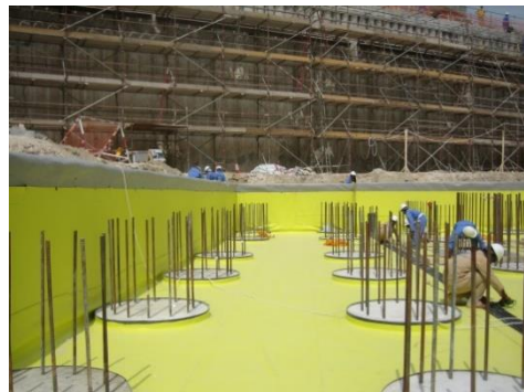
Montaż membrany na ścianie oporowej
