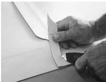
Ścinanie zakładki z podwójnego zgrzewu
