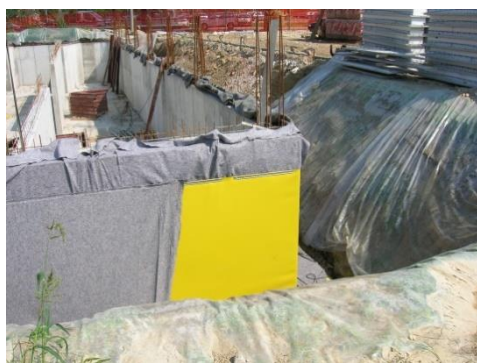
Montaż membrany na istniejących ścianach
