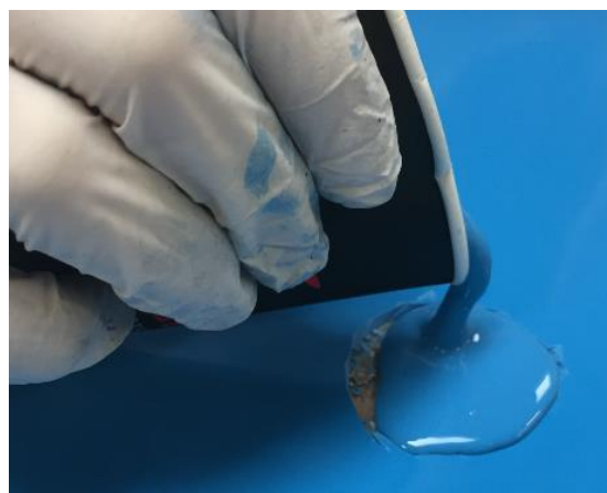
Fot. 7: Wypełnianie nacięcia
