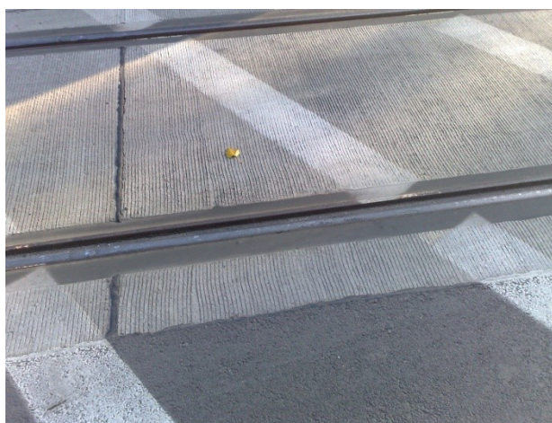
Fot. 2. Fragment nowego torowiska - przejazd przez jezdnię ul. Kocmyrzowskiej
