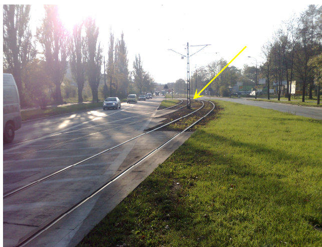
Fot. 1. Fragment torowiska klasycznego na podkładach na tłuczniu, zalane na przejazdach asfaltem.
