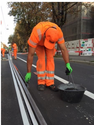
Zdjęcie 3: Posypywanie Sikaflex®-406 KC piaskiem kwarcowym
