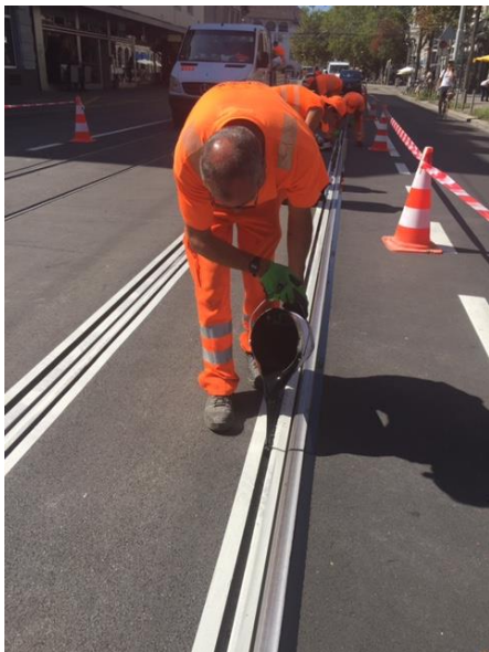
Zdjęcie 2: Aplikacja Sikaflex®-406 KC bezpośrednio z pojemnika
