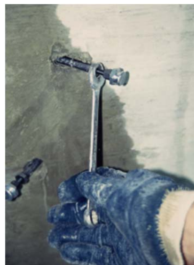
Dokręcanie kluczem
