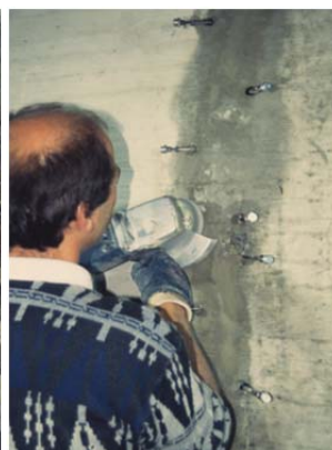
Usuwanie pakerów
