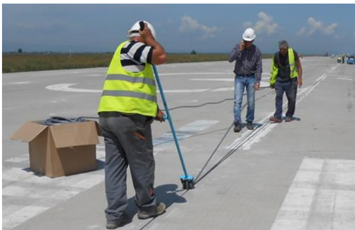
Zdjęcie 1: Układanie podparcia wypełnienia za pomocą narzędzi.
