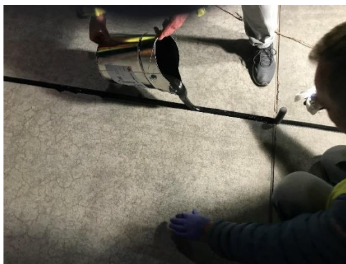
Zdjęcie 3: Aplikacja Sikaflex®-406 KC bezpośrednio z pojemnika
