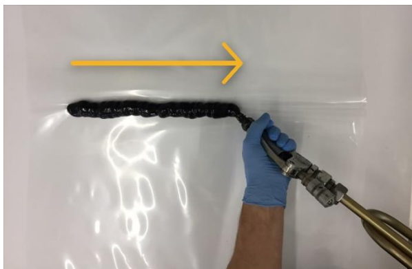
Zdjęcie 4: Nałożyć uszczelniacz wzdłuż zagięcia
