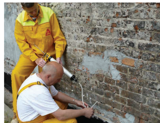
Zastosowano SikaMur® InjectoCream-100 w otworach o głębokości 110 cm nawierconych co 10 -12 cm.
