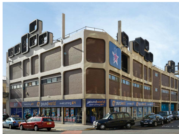
Budynki murowane ze szkieletem stalowym
