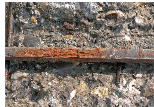
Uszkodzenie konstrukcji betonowej z powodu niewystarczającej grubości otuliny betonowej oraz niskiej jakości betonu.
