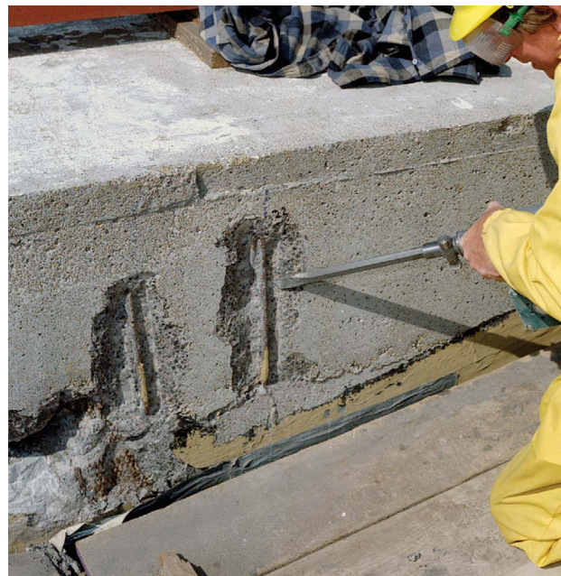
Uszkodzona konstrukcja betonowa
