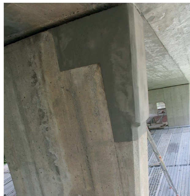
Zakończone prace naprawcze
