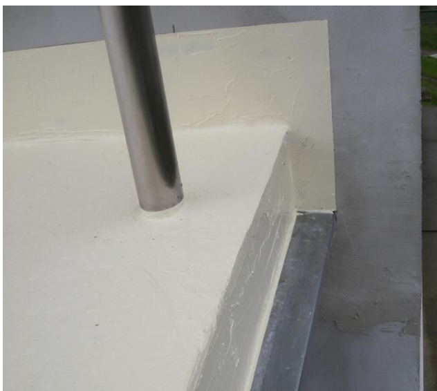
Izolacja na cokole z obróbką blacharską
