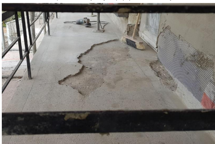
Ubytki podłoża
