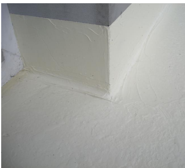
Izolacja na cokole
