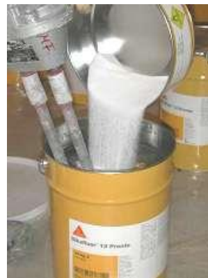
Jeśli mieszanka jest jednorodna dodać odpowiednią ilość utwardzacza.
