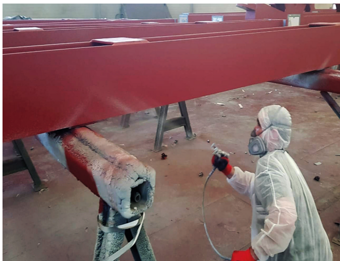
ZDJĘCIA UDOSTĘPNIONE DZIĘKI UPRZEJMOŚCI WYKONAWCY BUD-KOR SP. Z O.O
