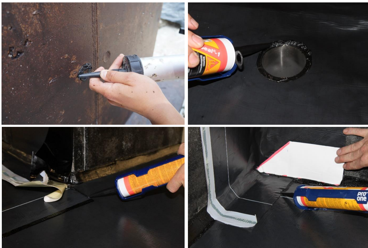
Zdjęcie 8. Sika BlackSeal-1 do uszczelniania detali i połączeń T
