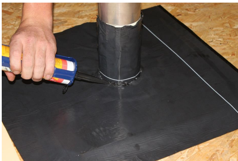
Zdjęcie 14. Materiał uszczelniający zamykający połączenie między membranami
