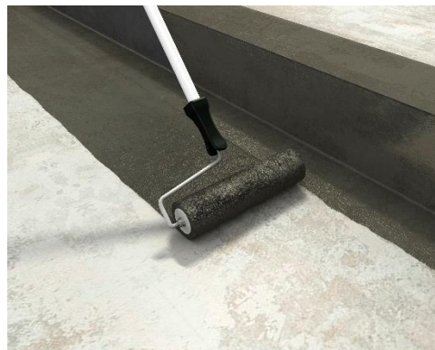
Zdjęcie 5. Gruntowanie
