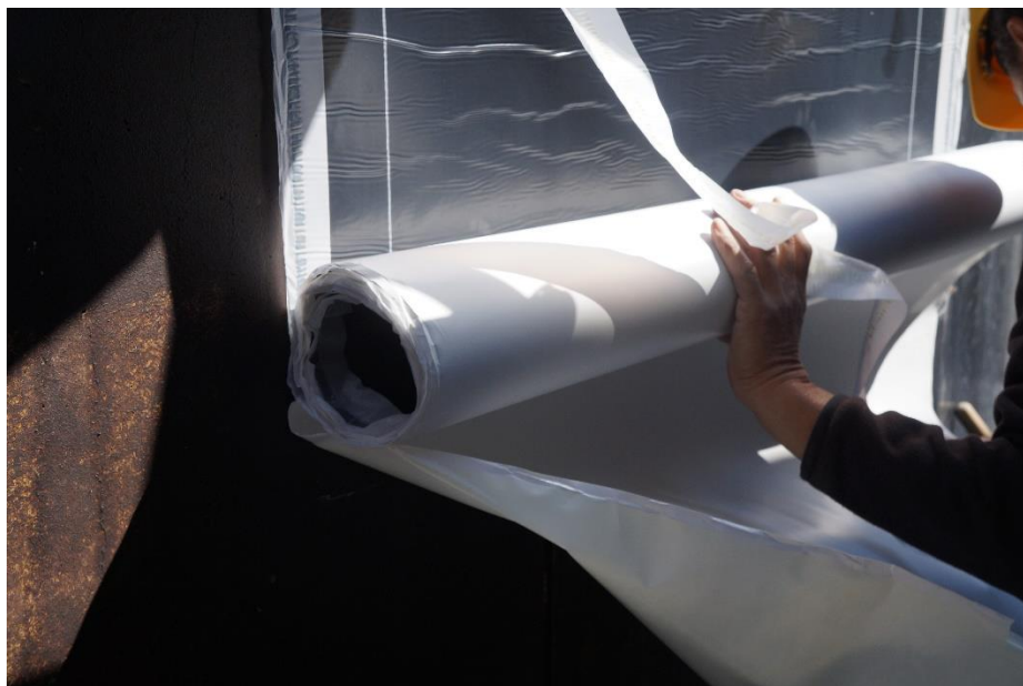
Zdjęcie 7. Aplikacja samoprzylepnej membrany - zaznaczona na białą linię zakładu.
