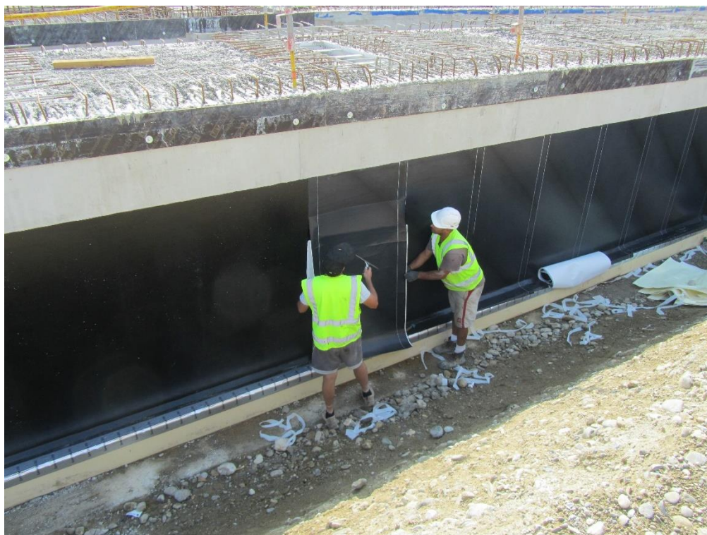
Zdjęcie 2. Membrana bitumiczna na ścianie oporowej (aplikacja pionowa)
