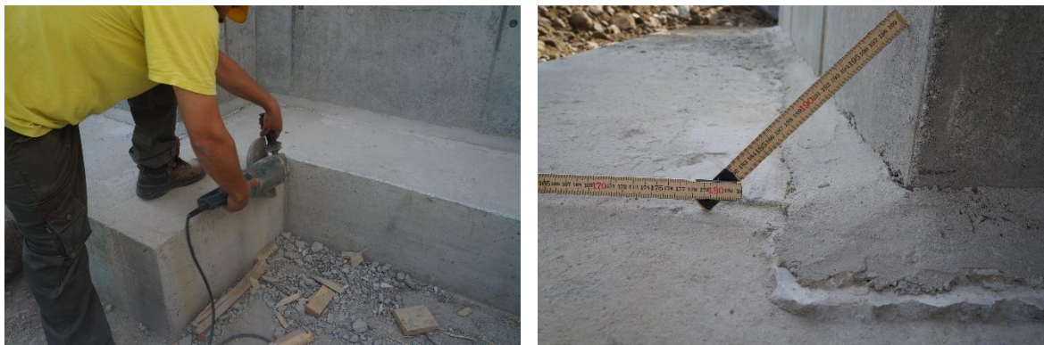
Zdjęcie 3. Przygotowanie podłoża
