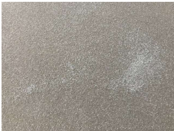
Powierzchnia Sikafloor®-151 z równomiernie rozłożoną posypką.
