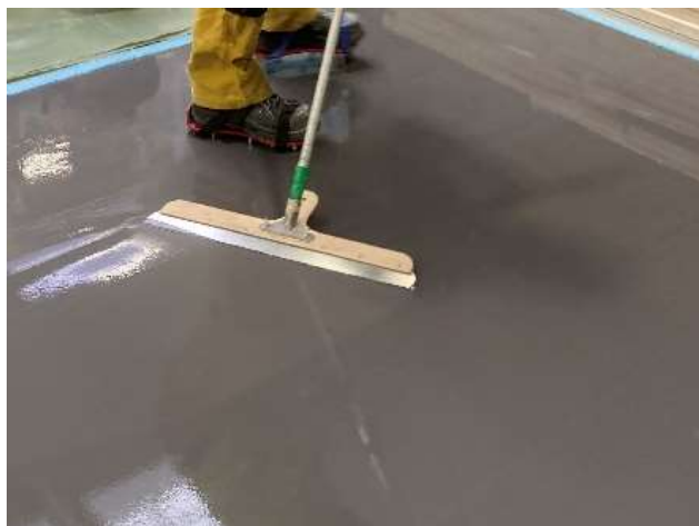
4. Wygładzanie pacą wygładzającą
