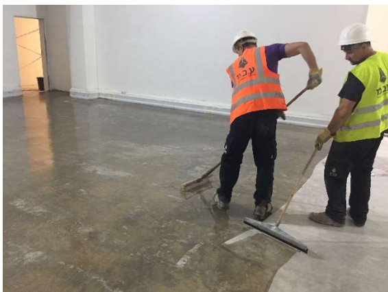
Aplikacja pierwszej warstwy materiału gruntującego
