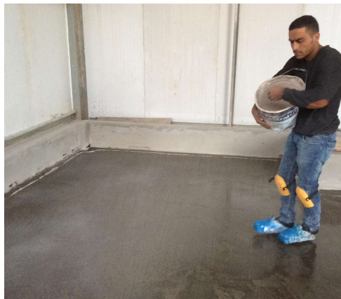
Układanie drugiej warstwy
