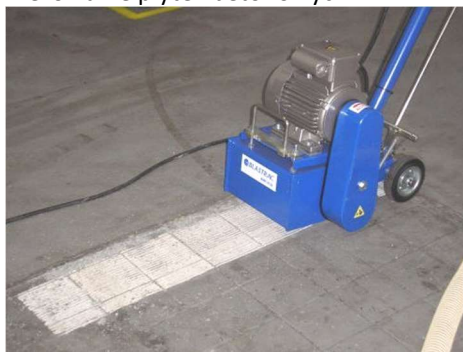
Frezowanie płytek betonowych
