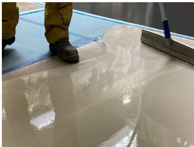
3. Rozprowadzanie rakłą
