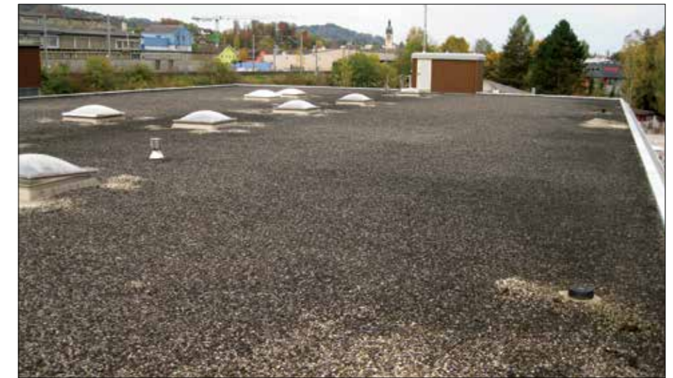
Rys. 4: Widok ogólny dachu budynku Brunner w Flawil (Szwajcaria)
