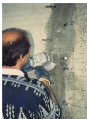
Usuwanie pakerów
