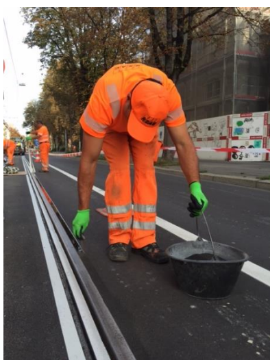
Zdjęcie 3: Posypywanie Sikaflex®-406 KC piaskiem kwarcowym
