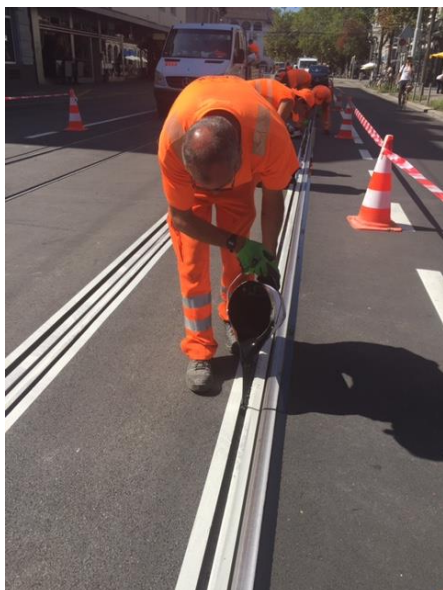
Zdjęcie 2: Aplikacja Sikaflex®-406 KC bezpośrednio z pojemnika
