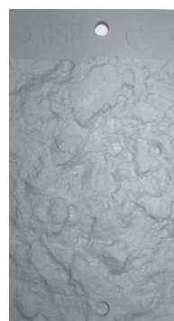
CSP-10 Ręczne śrutowanie a następnie obróbka strumieniowo-ścierna
